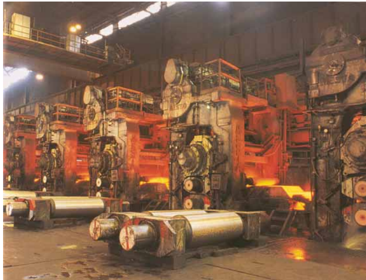
Figura 9.14 – Exemplo de laminador instalado em uma siderúrgica.
